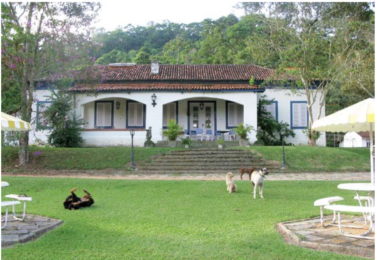
Fazenda Pinheiros, fachada principal
