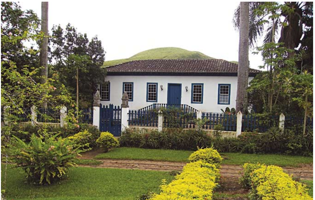
Fazenda Santa Bárbara, fachada principal
