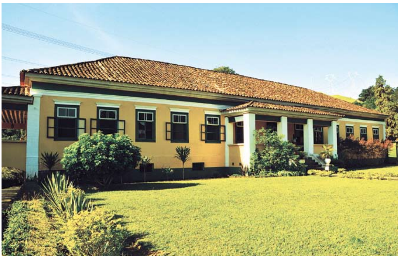
Fazenda Bocaina, fachada principal
