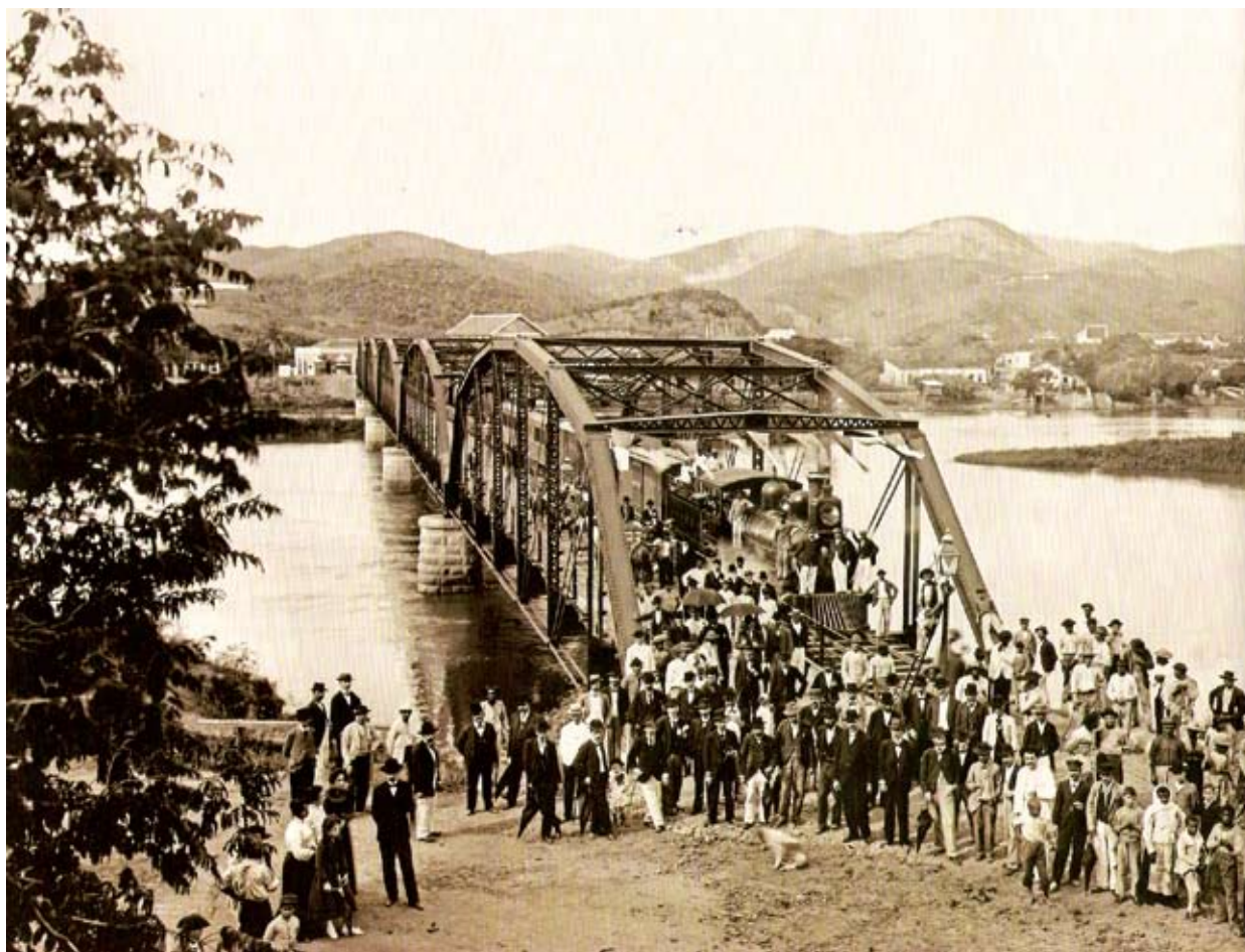
Ponte mista (ferroviária e de rodagem) sobre o Rio Paraíba. Barra do Pirai, c. 1888. Marc Ferez. Col. Gilberto Ferrez, IMS. VASQUEZ, Pedro Karp. Nos trilhos do progresso: A ferrovia no Brasil Imperial vista pela fotografia . Metalivros, Rio de Janeiro: 2007.p.163.
