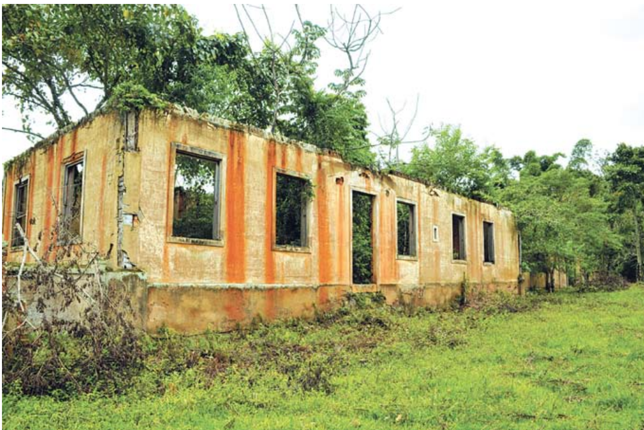
Fazenda São Benedito, ruína da fachada principal
