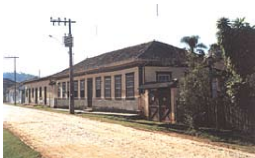
Residência com pé-direito baixo em São José das Três Ilhas, distrito de Belmiro Braga – MG.
