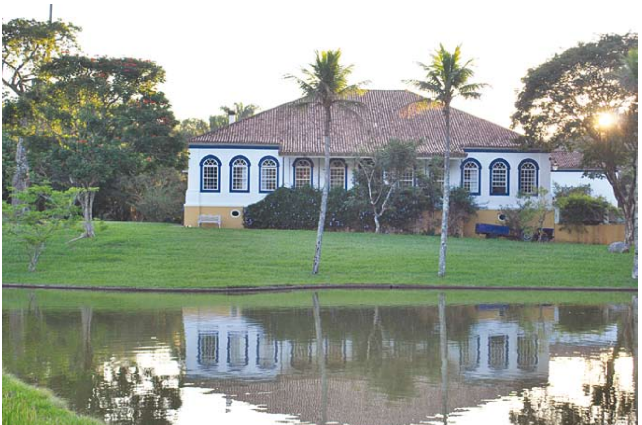
Fazenda das Palmas, fachada principal
