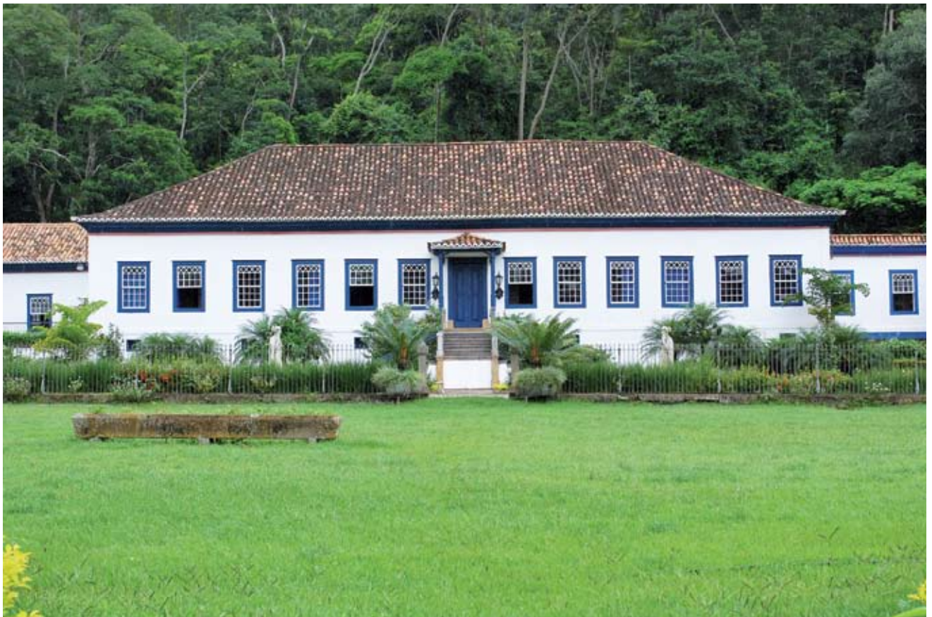
Fazenda São Fernando, fachada principal
