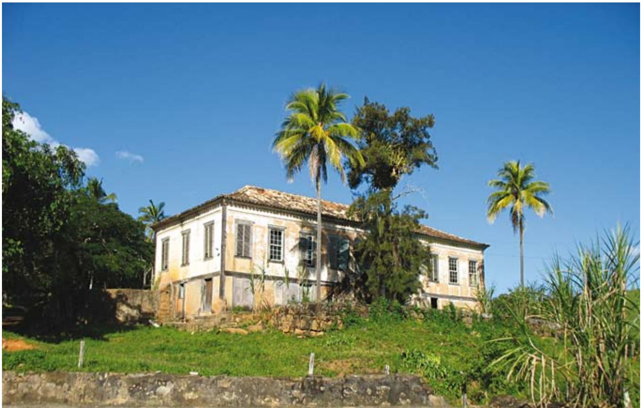
Fazenda Liberdade, fachada principal
