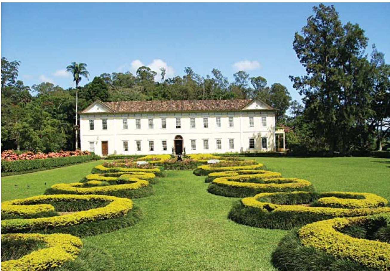
Fazenda do Secretário, fachada principal
