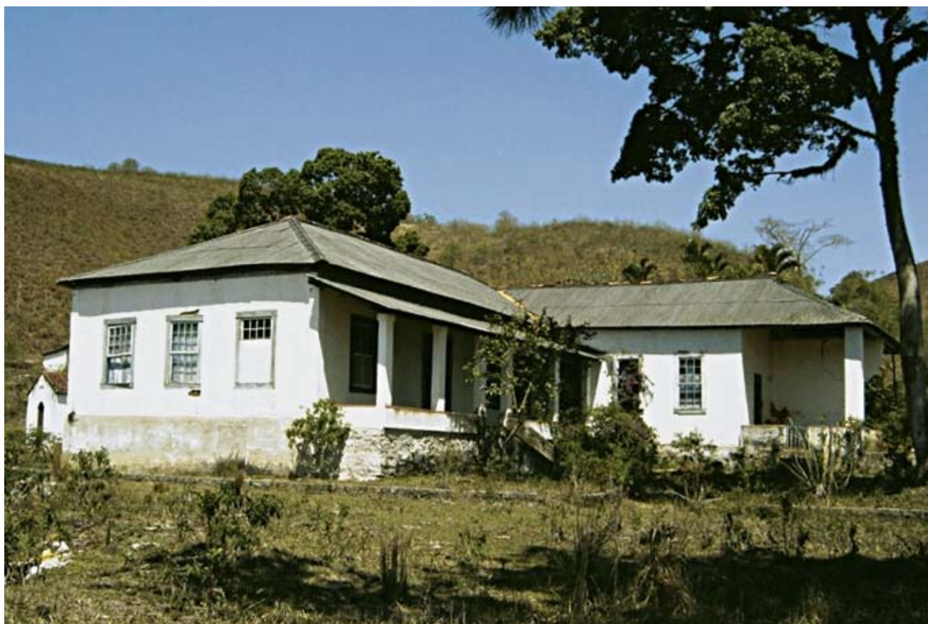
Fazenda Forquilha, fachada principal
