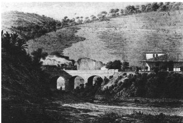
Estação de Rodeio e Viaduto. 5
