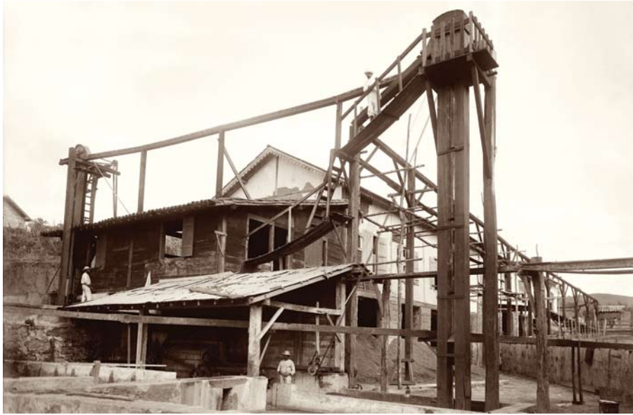
Fazenda Cachoeira Grande. Elevadores, esteiras. Abarracamento, Rio das Flores, RJ. Marc Ferrez. Coleção Gilberto Ferrez. IMS.
