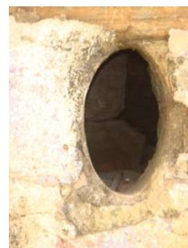
A casa-sede encontra-se em péssimo estado de conservação. A falta de revestimento nas fundações em pedra facilita a expansão da umidade existente em vários pontos.
