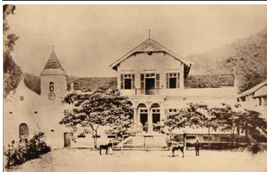
Foto antiga (final séc. XIX) da fachada
