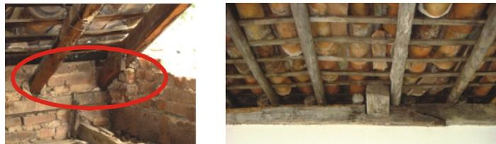
**Cimalha** – Elemento horizontal de arremate e ornamentação da parte superior da parede, junto ao beiral ou ao forro. Pode ser executada em madeira ou estuque.
