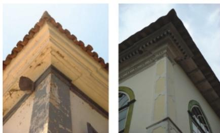
**Encachorrado** – Termo utilizado para denominar beirais sustentados por peças horizontais de madeira em balanço, chamadas *cachorros*. Essa denominação deve-se ao fato do seu desenho em perfil sugerir a cabeça de um cachorro.
