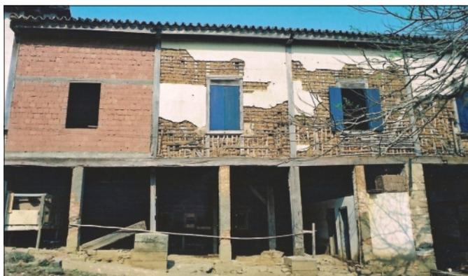
Substituição de pilares de madeira por alvenaria e do pau-a-pique por tijolo furado
